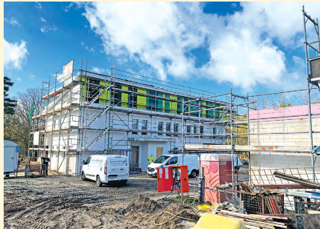
Noch wird emsig gewirbelt am neuen Betriebsgebäude auf der Tandemkläranlage des KMS in Zossen. „Wir liegen nicht ganz im Zeitplan, aber im Mai wollen wir alles an unseren Betriebsführer übergeben“, steckt Technikchef Christian Straube den Zeitplan fest.
