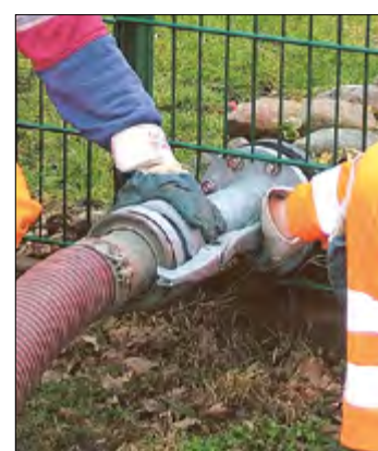
Ein Anschlussstutzen an der Grundstücksgrenze erleichtert die Entsorgung für Kunden und Entsorger gleichermaßen.
