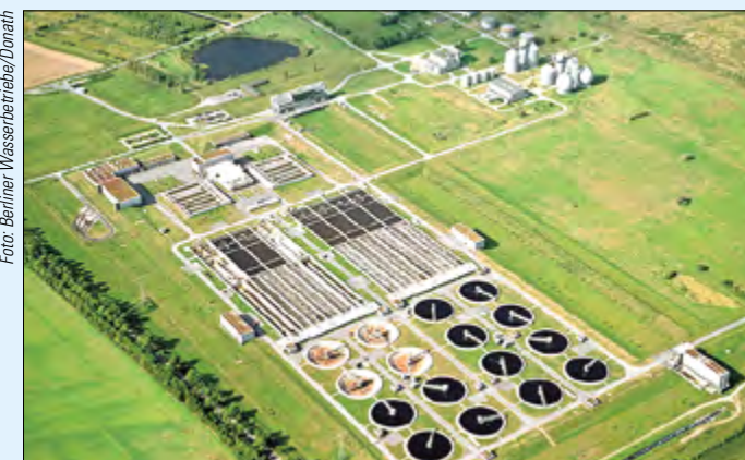
Die Kläranlage Waßmannsdorf gehört zu den leistungsfähigsten der Region. Sie hat eine Tageskapazität von 230.000 m 3 Abwasser (bei Trockenwetter).
