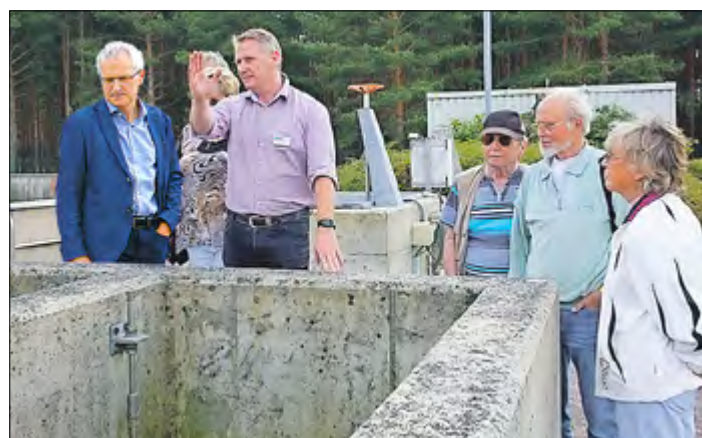
Interessierte Bürgerinnen und Bürger nutzen die Möglichkeit, einen Blick hinter die Kulissen der Abwasserreinigung in Alt Schadow zu werfen. Abwassermeister Dirk Frambach (Mitte) führte durchs „Programm“.
