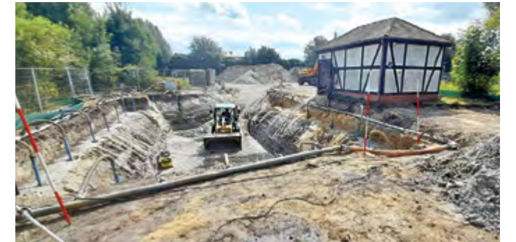
Der Ersatzneubau der Kläranlage Beesdau wird voraussichtlich im Frühjahr 2022 abgeschlossen.
