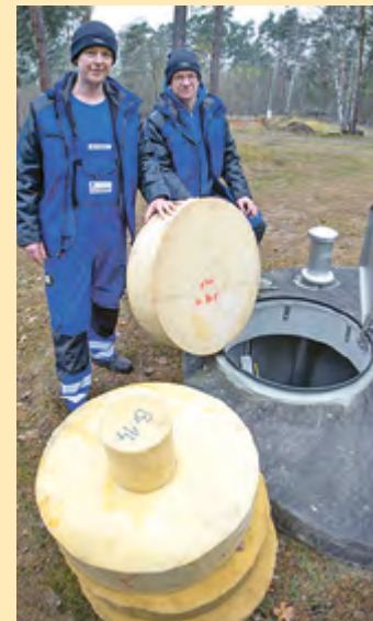
Die Schaumstoffdämmplatten werden unter die Deckel der Brunnenstuben geklemmt.
