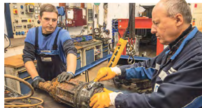
Svyatoslav Nikitin (li.) und Peter Hirschmann aus der Mechanischen Werkstatt der DNWAB gehen dem Problem dieser Abwasserpumpe auf den Grund und setzen sie wieder instand.
