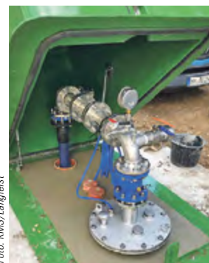
Der ehemalige Erkundungsbrunnen hat diese neue Brunnenstube erhalten.
