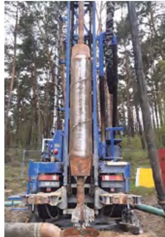
Mittels Spezialtechnik werden neue Brunnen gebohrt. Foto: WARL
