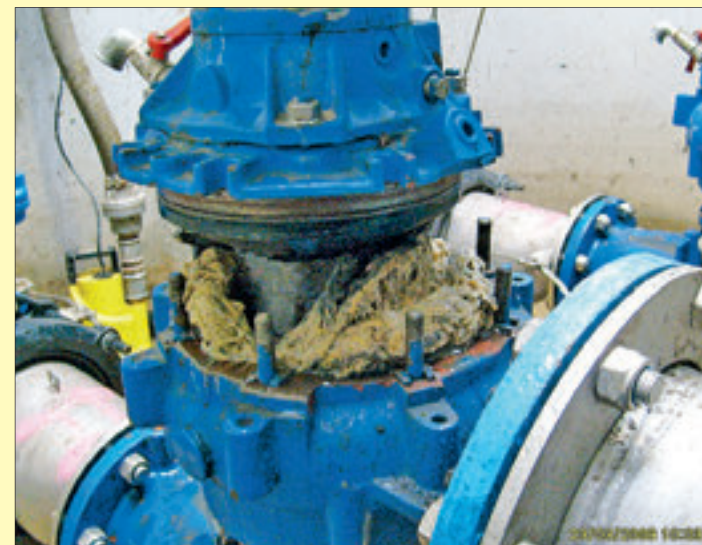
Gegen die Masse an reißfesten Reinigungstüchern hatte die Pumpe in der Mahlower Dorfstraße keine Chance. So wiederholt sich das im Zuständigkeitsbereich des WAZ Blankenfelde-Mahlow auch in der Beethoven-, Mozart- und Vivaldistraße, in Heuweg und Rädlerwald.
