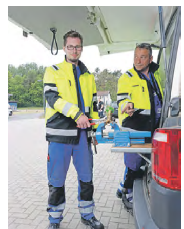
Hannes Beldner (li.) und Robert Neujahr reparieren beim Zählerwechsel vor Ort ein Ventil.
