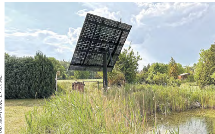
Im Wasserwerk Bad Saarow wird eine solche sonnenstandgeführte Anlage gebaut. Sie dreht sich automatisch der Sonne zu.
