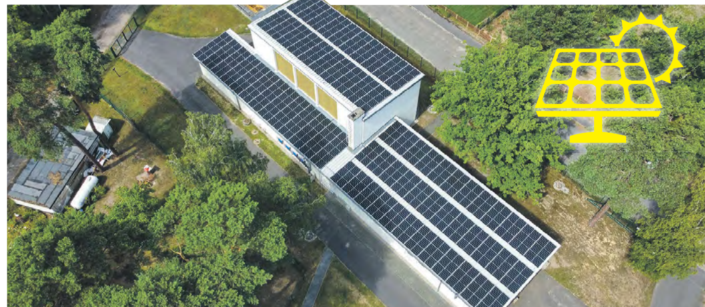
Photovoltaik-Paneele satt auf den Gebäuden des Wasserwerks Storkow.
