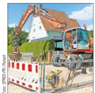
Kollegen von TRP aus Wildau setzen in der Straße „An den Sümpfen“ die neuen Vakuumschächte für die Grundstücksanschlüsse.
