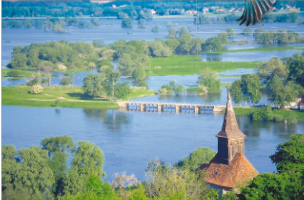
Frühjahrshochwasser am Saathener Wehr an der Oder mit den gefluteten Poldern A und B. Das in den Jahren 1906 bis 1928 nach holländischem Vorbild errichtete Poldersystem bestimmt bis heute das Geschehen in der Aue. Die Flutungspolder können bis zu 130 Mio. m 3 Wasser aufnehmen.
