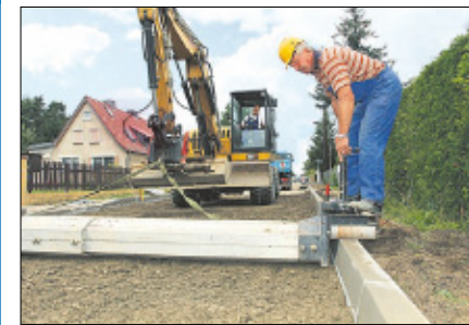
Sinnvolle Synergie – im Birkenweg und in der Wilhelm-Busch-Straße im Ludwigsfelder Wohngebiet „Gartenstadt“ wurden die Sanierungsarbeiten am Schmutzwasserkanal (721 m) parallel mit dem Straßenbau ausgeführt.
