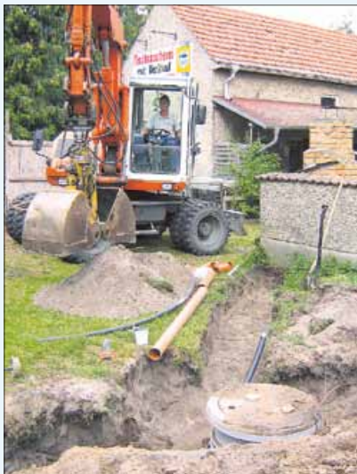
Schachtarbeiten für einen neuen Hausanschluss.
