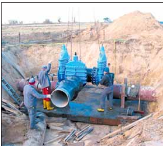
Bau einer Abwasserdruckleitung für den MAWW in Ragow.
