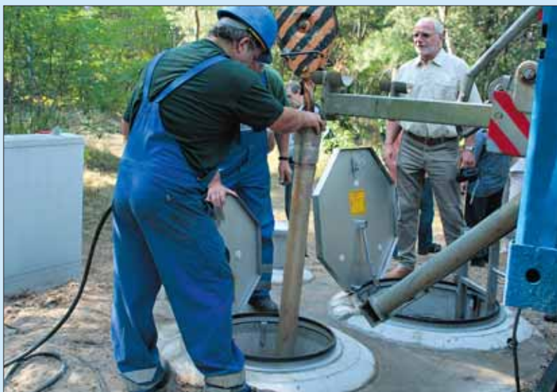
Einbau einer energiesparenden Pumpe im WW Ludwigsfelde, geliefert von „Rodeike“.
