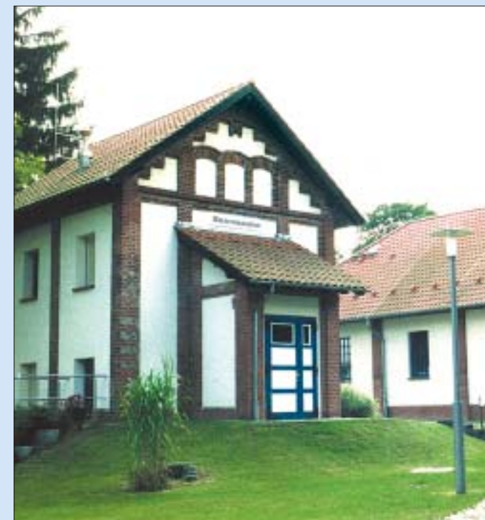
Sanierte Wasserwerke – Säulen des Trinkwasserverbunds.
