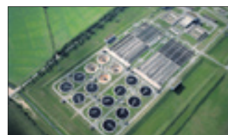
Der WAZ Blankenfelde-Mahlow leitet sein Schmutzwasser auf die Kläranlage der Berliner Wasserbetriebe nach Waßmansdorf
