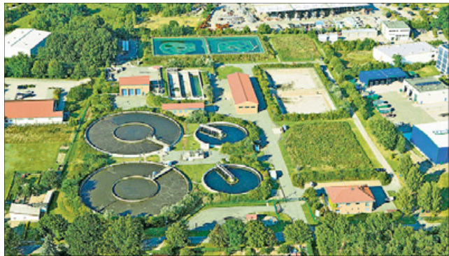
Die 2001 fertiggestellte moderne vollbiologische Kläranlage in Ludwigsfelde wurde im selben Jahr einer Umweltprüfung unterzogen und ist seitdem gemäß DIN EN ISO 14001 zertifiziert.
