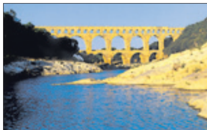
Der zwischen 40 und 60 n. Chr. errichtete 50 m hohe Pont du Gard bei Nîmes ist wohl das bekannteste Brückenquädukt der Römer. 40.000 m 3 Wasser wurden hier täglich nach Nîmes transportiert.
