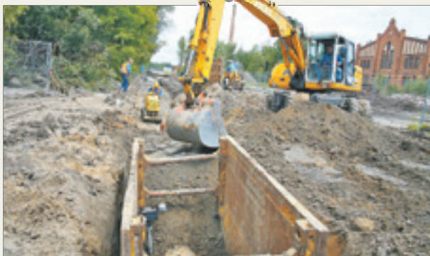
Aushub für die neu zu verlegende Trasse der Regenwasserableitung in Wildau.
