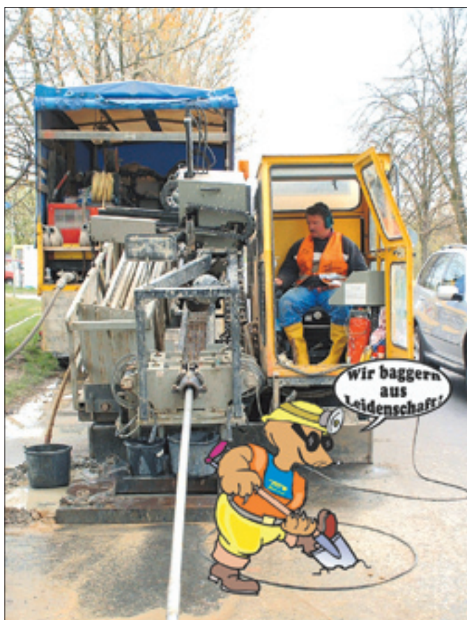
Die Mitarbeiter von Tief- und Rohrleitungsbau stellen mit Hilfe der Horizontalbohranlage Leitungsnetze in der modernen grabenlosen Technologie her.
