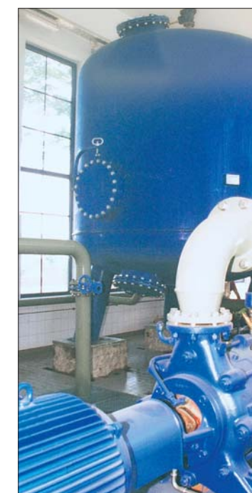
Sanierte Anlage im Wasserwerk Wildau.
