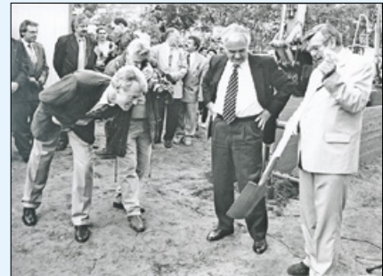
Historischer Tag im Oktober 1998: Landrat Martin Wille, Ministerpräsident Manfred Stolpe und MAWV-Verbandsvorsteher Siegfried Zimmermann-Stellmach (v. l.) beim ersten Spatenstich für das ZEWS-Projekt. Stolpe sagte damals: „Was hier in Gang gesetzt wird, verbessert die Lebensbedingungen erheblich.“ Er sollte Recht behalten!
