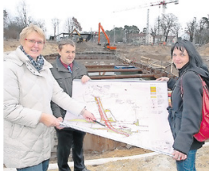
Lokaltermin in Rangsdorf: Bauamtsleiterin Simone Götsche, Bürgermeister Klaus Rocher und KMS-Chefin Heike Nicolaus (v. r.) begutachten die Großbaustelle der Bahn im Herzen der Gemeinde.
