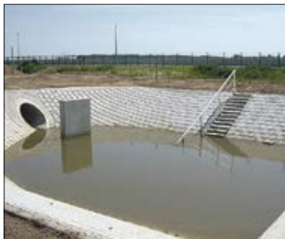
Regenrückhaltesystem am EXPOCENTER Selchow. Wichtige Bauteile kamen dabei aus dem Hause BERDING BETON.
