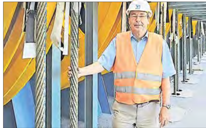
Peter Huth packt kräftig zu – hier in der noch offenen Seilrollenhalle im neuen Schiffshebewerk. Die Stahlseile sind hier 60 mm stark.
