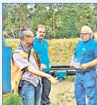
Wolfgang Kauert berät mit den Ingenieuren Klenke und Schulze (v. re.) die nächsten Arbeitsschritte.
