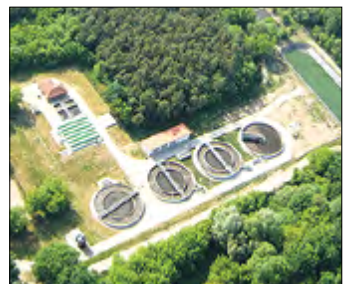
Die Tandemkläranlage Zossen-Wünsdorf (hier der Zossener Teil) bekommt bis zum Jahr 2020 eine zusätzliche Schlammbehandlung.
