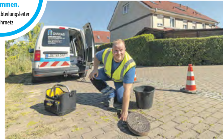
... und setzt einen Datenlogger zur Druckmessung ein.
