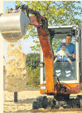
Kinderleicht? Ein Mitarbeiter der DNWAB zeigt, wie man baggert.
