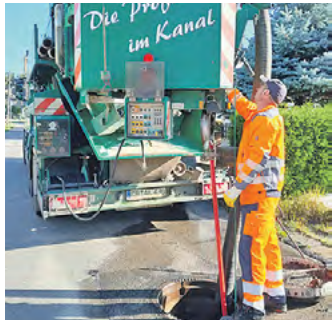
Zuerst werden mittels Hochdruckspülverfahren Ablagerungen von den Rohrwänden gelöst und abgesaugt.
