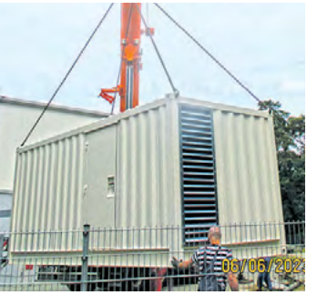
Anfang Juni setzte ein Kran das Aggregat an seinen geplanten Platz.
