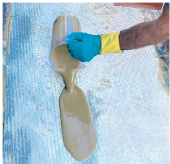
Vor Ort schneiden die Fachleute dann ein schadengroßes Stück Glasfaser-Laminat zu und tränken es beidseitig mit Komponentenharz.
