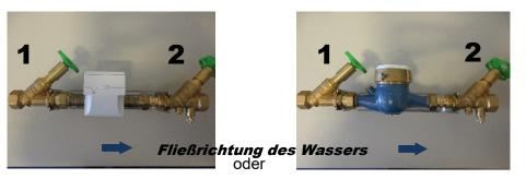
Das Freistromventil dient als Hauptabsperrarmatur für die Trinkwasserhausinstallation.
